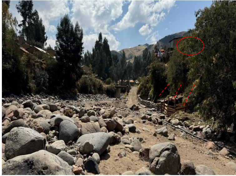
FIGURA N°01: TRAMO I SE MUESTRA VIVIENDAS CERCANAS AL MARGEN DEL RIO Y ANTE UNA EVENTUAL ELEVACION DE CAUDAL SERIAN AFECTADAS, DONDE SE PLANTEA MUROS TIPO GAVION
